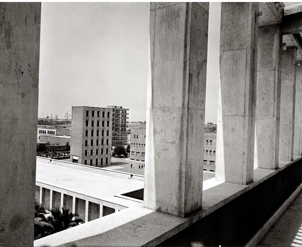
Fig. 33 - I castelli di manovra K1 e K2 (in costruzione)
