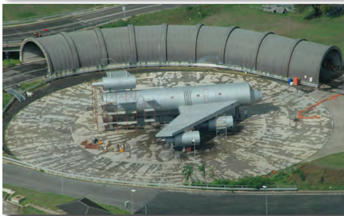
Figg. 95 e 96 - Due immagini dall'alto della Scuola di Formazione Operativa
