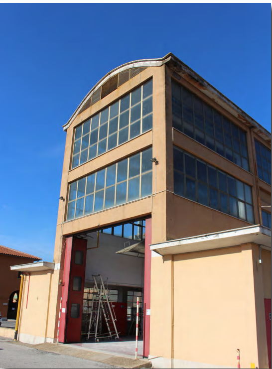
Fig. 73 - Edificio del forno per le prove di resistenza al fuoco dei materiali
