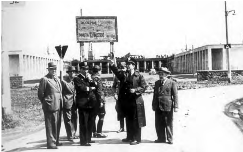
Fig. 9 - L'ingresso delle Scuole con l'edificio principale in costruzione. In primo piano il Prefetto Alberto Giombini (1940)
