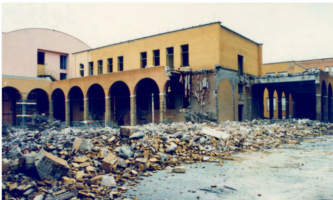
Fig. 52 - Demolizione di uno degli edifici della Scuola AVVA
