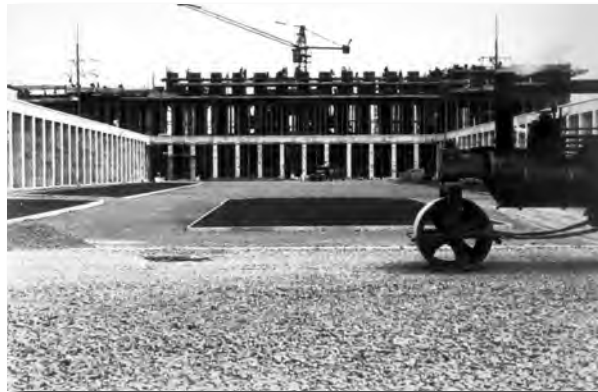
Fig. 8 - Via di Capannelle, in fondo le Scuole Centrali Antincendi in costruzione
