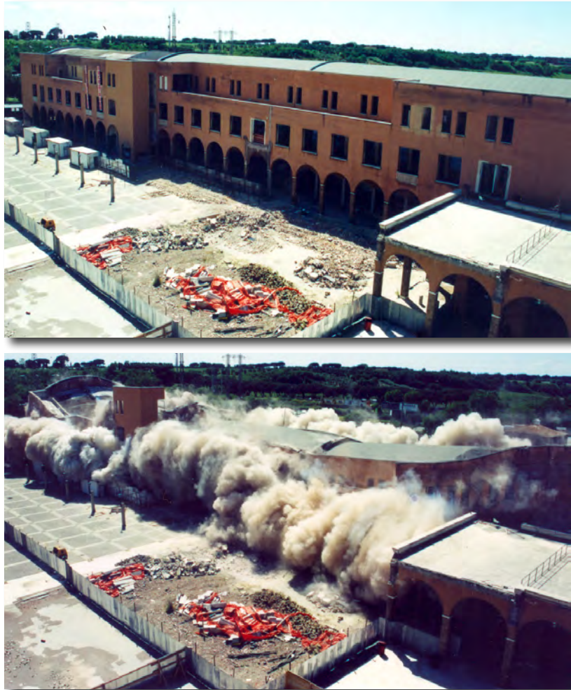
Figg. 50 e 51 - Sequenza della demolizione del vecchio edificio della mensa degli AVVA
