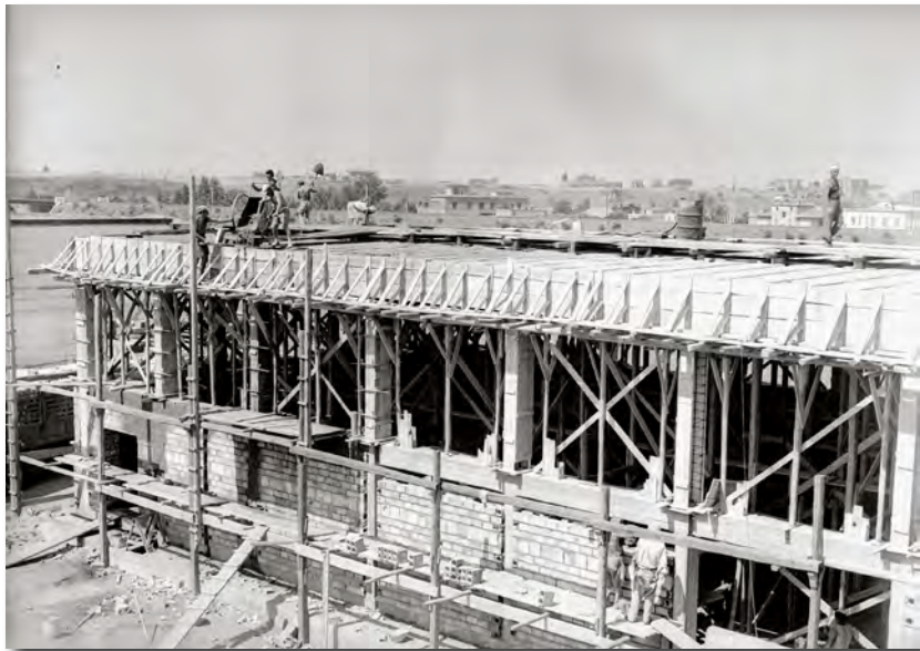
Fig. 28 - Lavori di ampliamento del complesso delle Scuole
