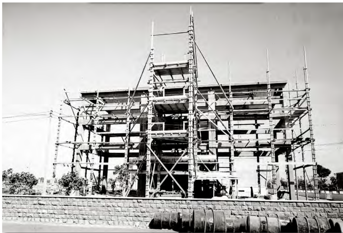
Fig. 29 - Lavori di ampliamento del complesso delle Scuole
