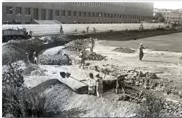
Fig. 30 - Castello di manovra K2 in costruzione
